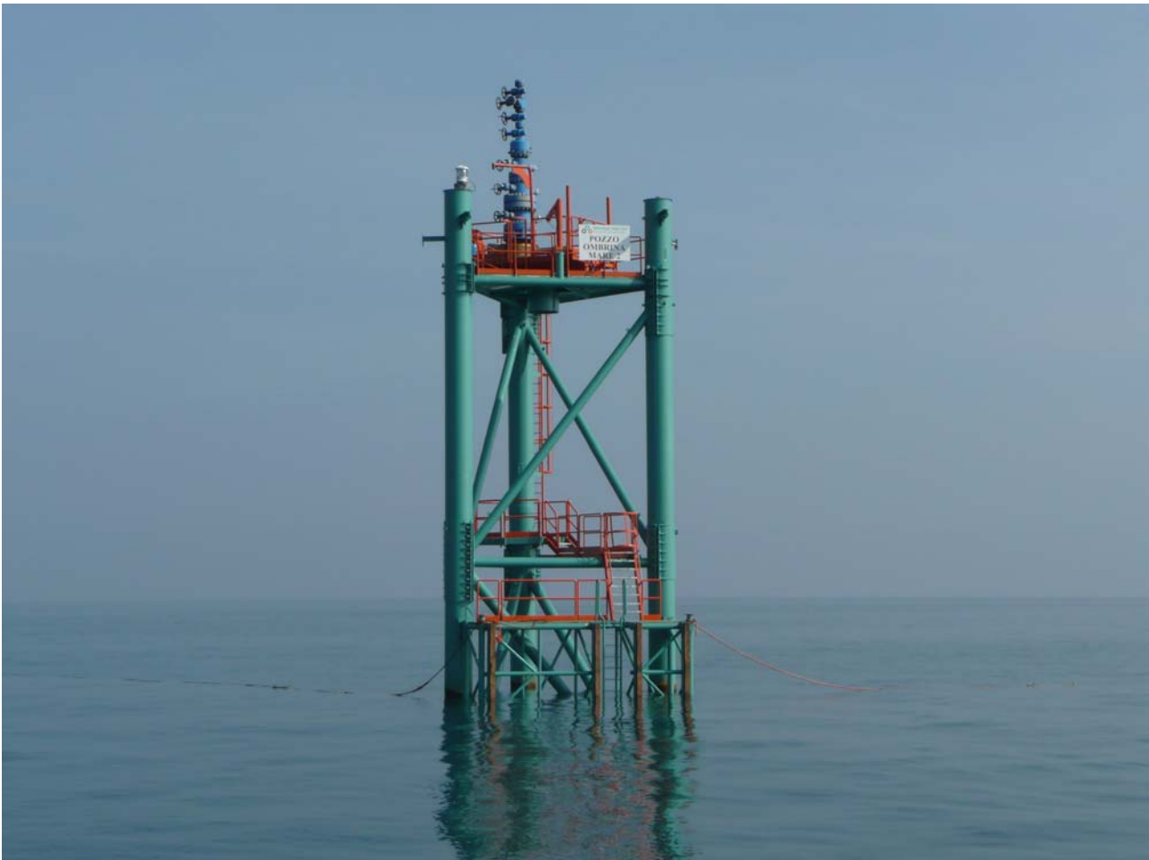
Figura 3.6.2.n – Pozzo Ombrina Mare 2 - Struttura a traliccio (tripode) di sostegno.
