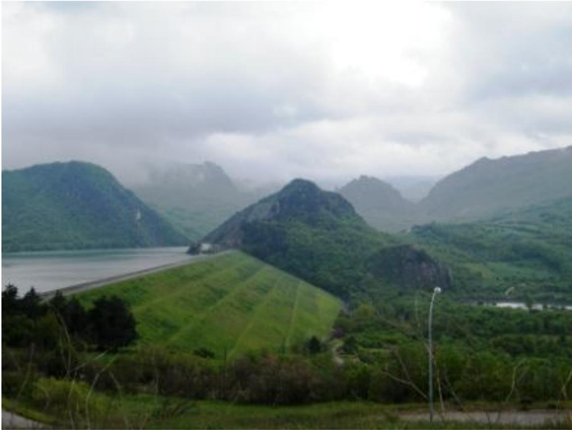
FIG. 2: La diga del lago di Bomba costruita negli anni 1950, in terra battuta e non in cemento a causa dei forti rischi idrogeologici. La diga e' alta 57 metri e il suo cedimento causerebbe il riversamento di ben 4 miliardi di litri di acqua.
