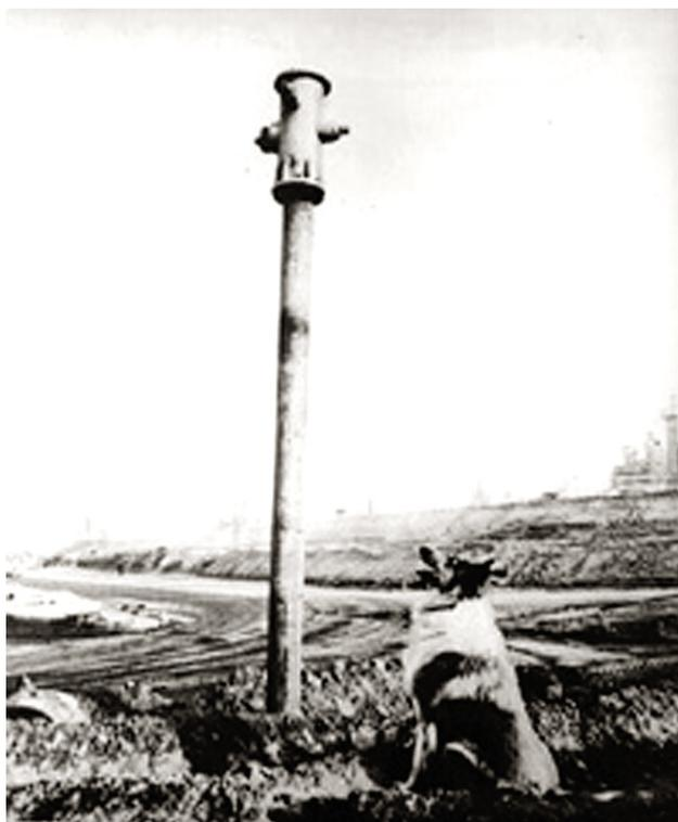
FIG. 15: Subsidenza del terreno dovuta all'estrazione di idrocarburi a Long Beach, California durante gli anni 1920. L'oggetto in cima al palo e' un idrante.
