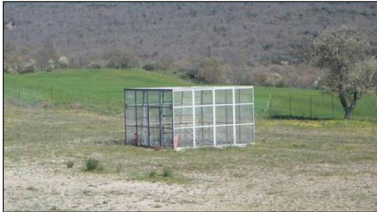
**Figura 4.3** Esempio di pozzo completato e recintato con gabbia metallica (con demolizione delle superfici impermeabilizzate)
